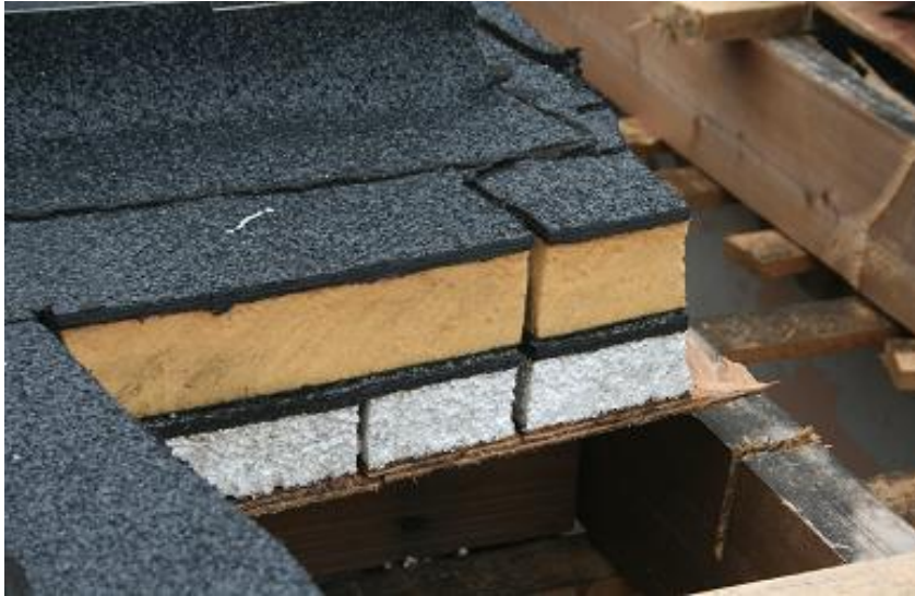
Opbouw dakconstructie na 1980/1981 en 1991
