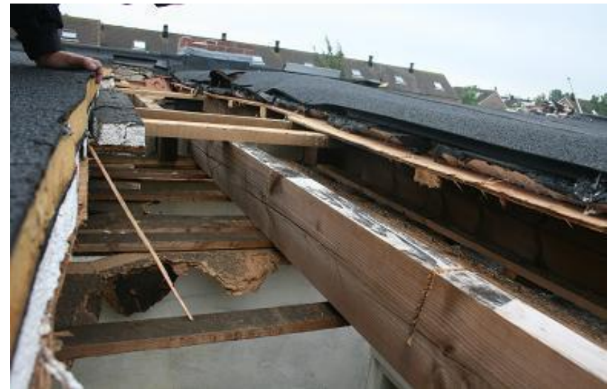
Balken, stuiknaadregels en zachtboardplafond
