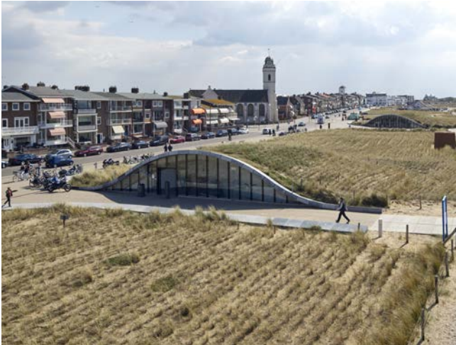
In Katwijk komen waterveiligheid, bereikbaarheid en toerisme samen in één toekomstbestendige ingreep. De aangelegde duinenrij met geïntegreerde dijk beschermt de kust, biedt ruimte aan een ondergrondse parkeergarage en versterkt de gebruiks- en belevingswaarde van de boulevard.
