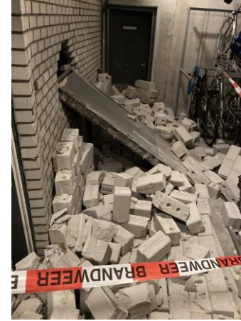
Muur tegen muur gestort
