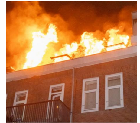
Asbest verdacht dak
