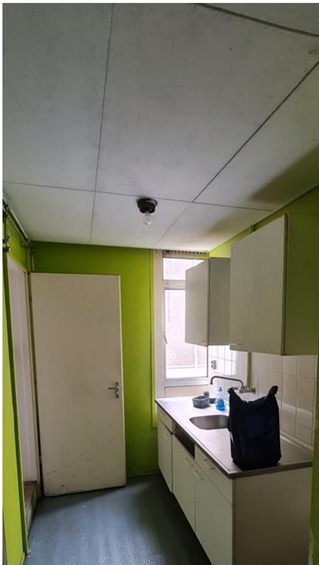
Situatie voor de renovatie
