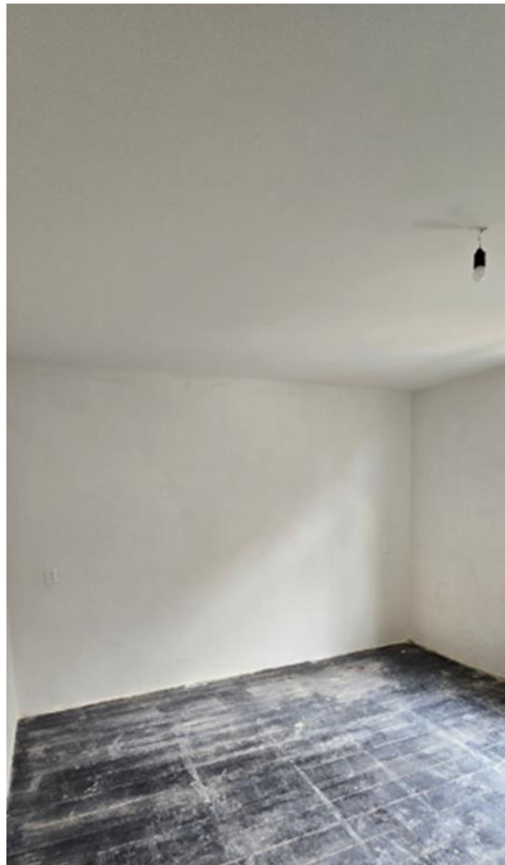
Situatie na de renovatie
