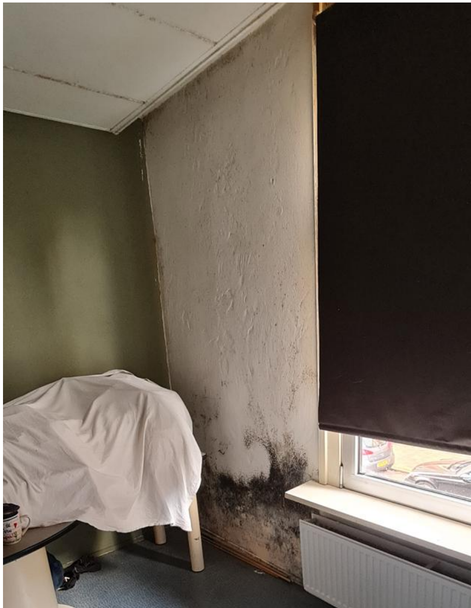
Situatie voor de renovatie
