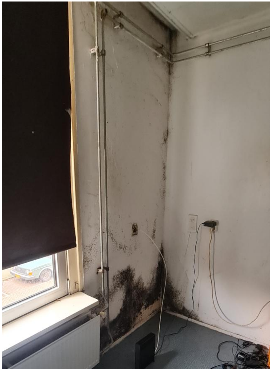
Situatie voor de renovatie
