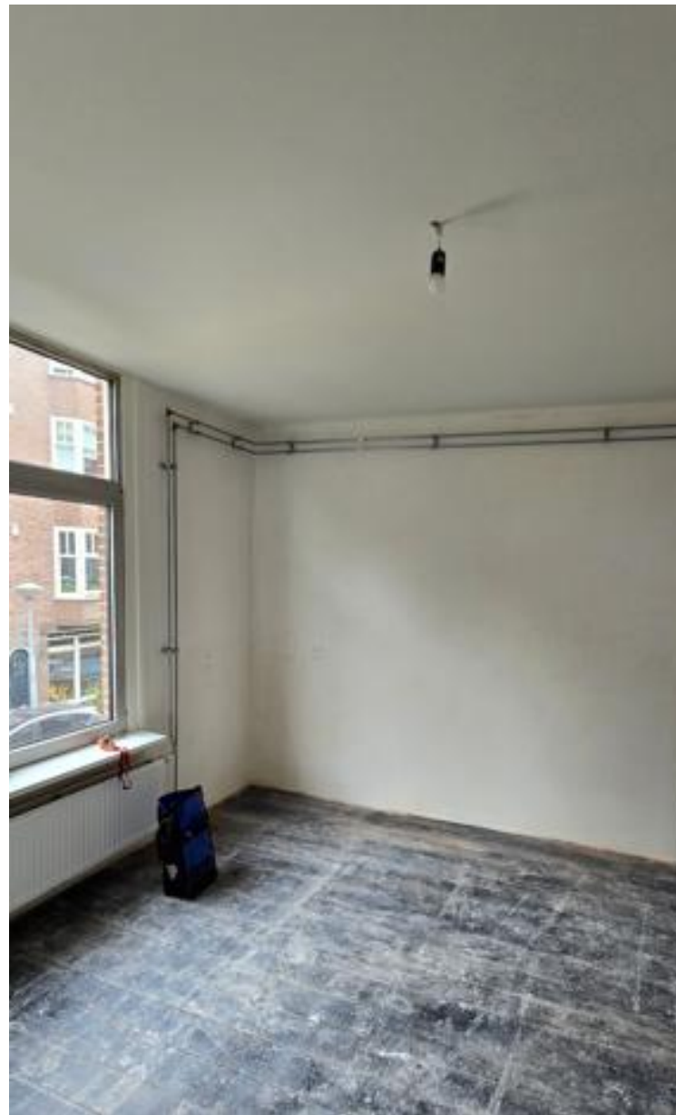
Situatie na de renovatie
