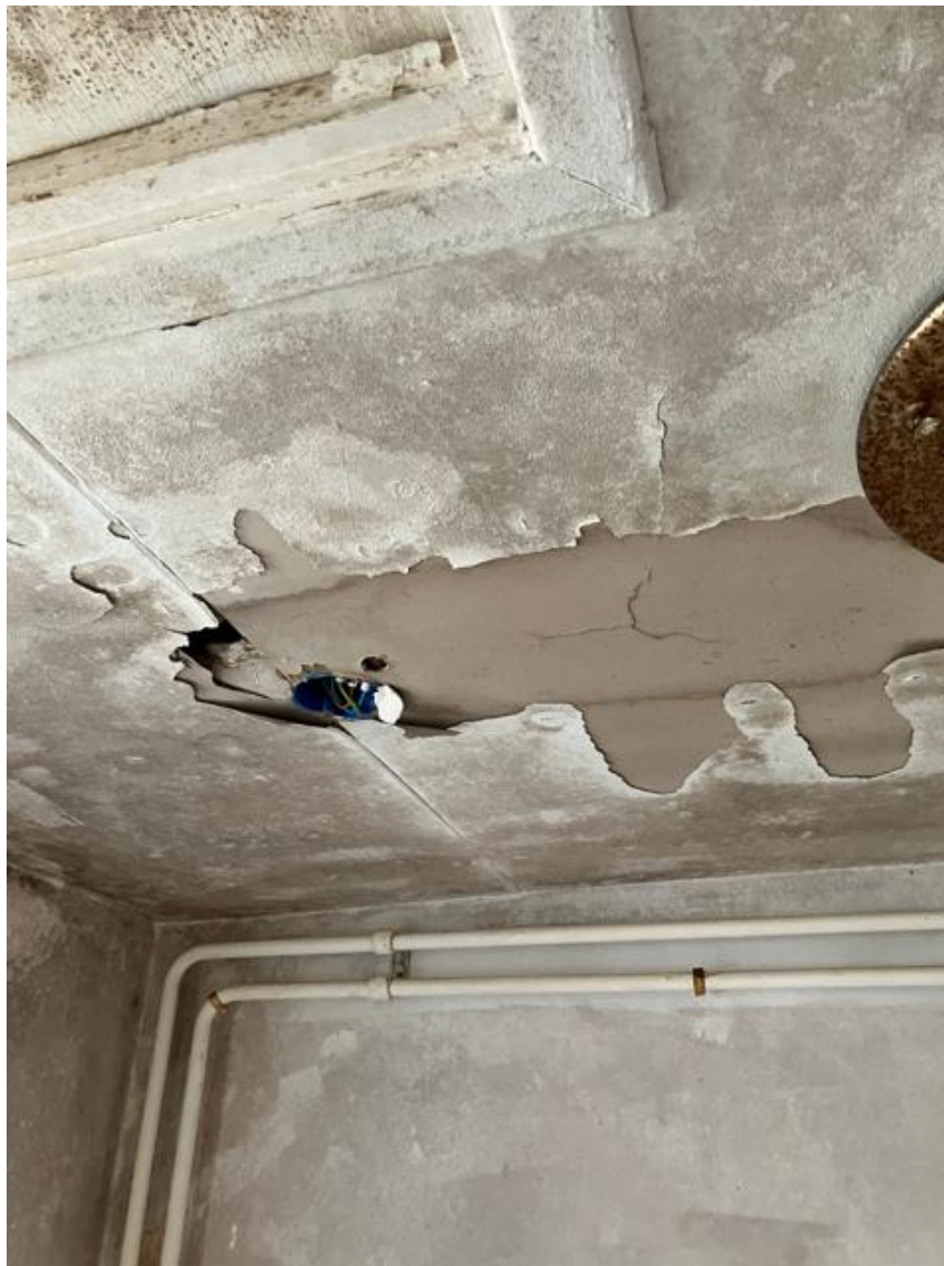
Overloop op de bovenste verdieping
