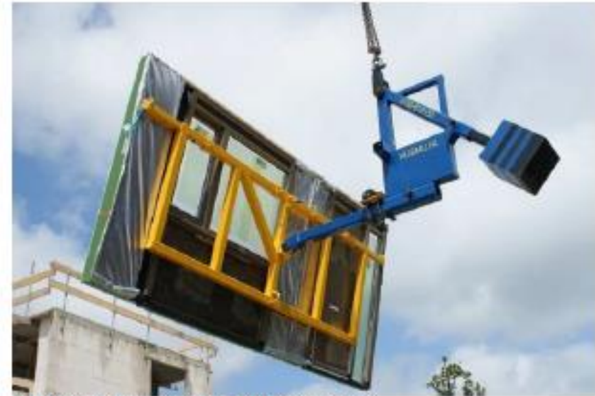
Afbeelding combisteker met gevelelement
