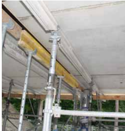
Hoe herken ik een breedplaatvloer? Door een observatie van het gebouw is vast te stellen of er breedplaatvloeren zijn toegepast. Bij gebruik van breedplaatvloeren is aan de onderzijde van een vloer vaak een naad zichtbaar die zich op een hart-op-hart-afstand van 2,40 meter of meer bevindt (zie foto). Bij een hart-op-hart-afstand tussen de naden van 1,20 meter is er in het algemeen sprake van een kanaalplaatvloer. Als er geen naden zichtbaar zijn en de vloer is aan de onderzijde voorzien van stucwerk, dan is de vloer veelal ter plaatse gestort. Foto: Frank de Groot.
