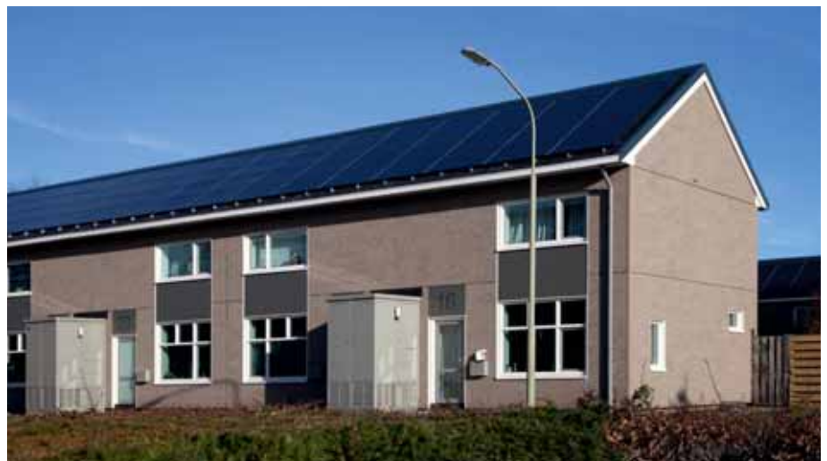
In Emmen zijn door BAM Wonen 48 rijwoningen uit de jaren vijftig nul-op-de-meter (NOM) gemaakt. Voor de huidige gevels zijn gevelelementen geplaatst met steenstrips. De woningen zijn voortaan 'all-electric' door het plaatsen van onder andere zonnepanelen, een warmtepomp en een warmte-terugwin-installatie. Oplevering was begin 2019.
