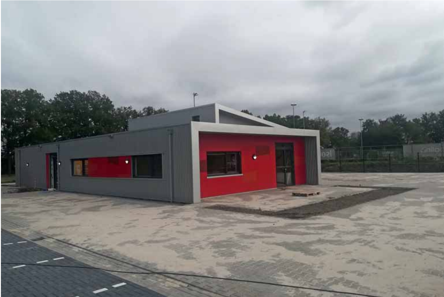
Proefproject Brandweerkazerne Glanerbrug. Foto en kwaliteitsborging: PlanGarant.
