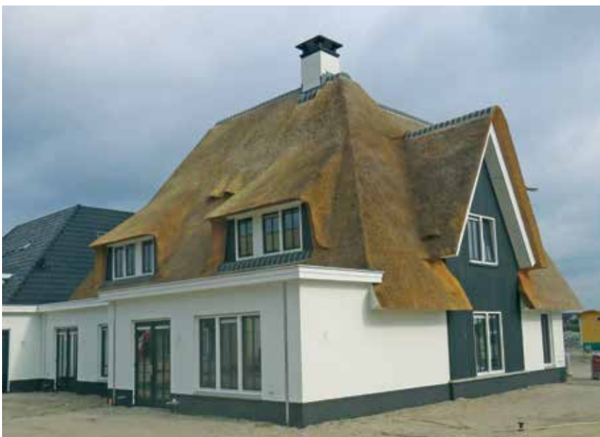
Rieten dak bij project in Blaricummeent: schroefdak dat bovendien brandvertragend is behandeld.
