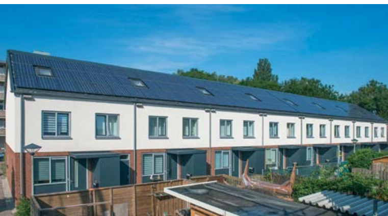
Bij de brand in Arnhem ging het om een woonblok met acht woningen van woningcorporatie Portaal. De zonnepanelen lopen door over het dak.
