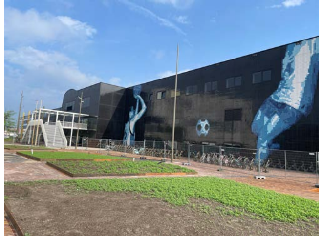
Topsportcentrum Almere. De gevels zijn afgewerkt met gelijkde zwarte tegeltjes. Na bijna 20 jaar nog geen schade.
