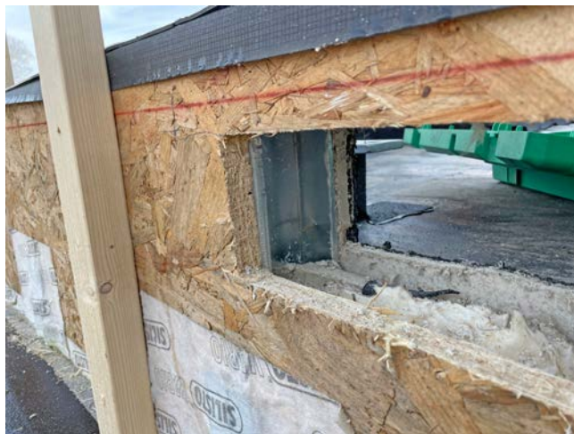
Staalframebouw met een afwerking van houtvezelplaten.
